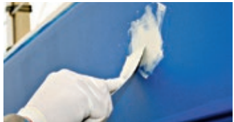
Udfyld ujævnheder med spartel
