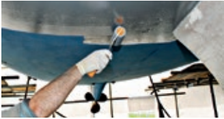
Påfør Hempel's High Protect med rulle
