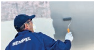
Påfør Hempel's Underwater Primer på overfladen
