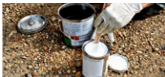
Rør i hærderen
