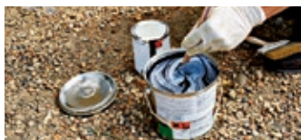
Rør blandingen grundigt
