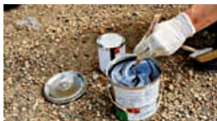
Rør blandingen grundigt
