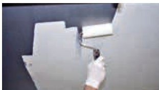
Påfør bundmaling oven på primer eller hæfteprimer
