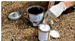
Rør i hærderen
