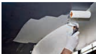
Påfør bundmaling oven på grunderen
