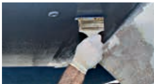
Overstryg Hempel's High Protect i modsat retning med pensel
