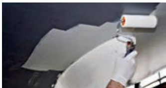
Påfør bundmaling oven på grunderen
