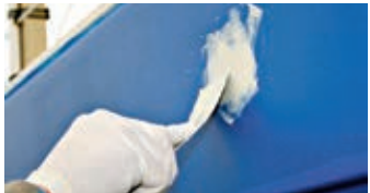
Udfyld ujævnheder med spartel
