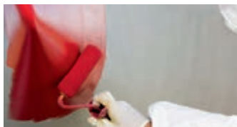
Påføring af bundmaling
