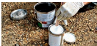
Rør i hæderen
